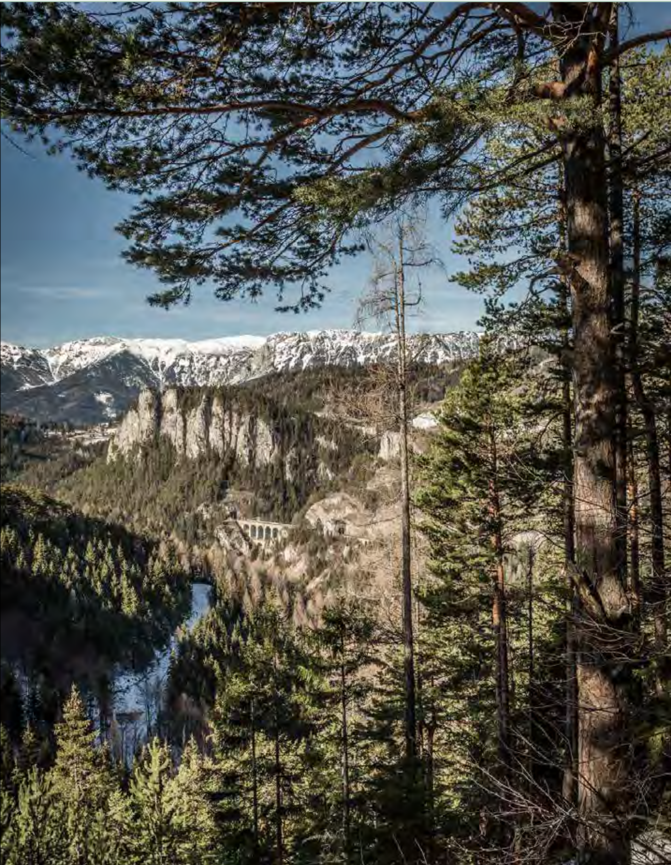
Viadukt der 1854 eröffneten Semmering- bahn an der Krauselklause
